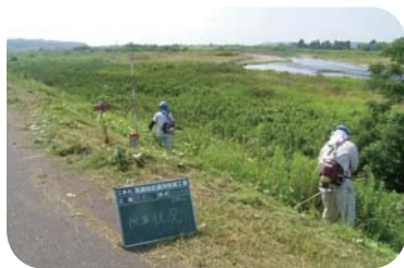
○堤防除草作業
