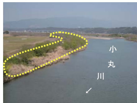
○河道内に繁茂する樹木群
