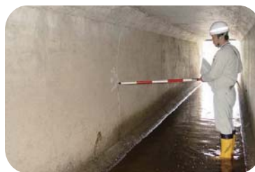
○樋門の保守点検
