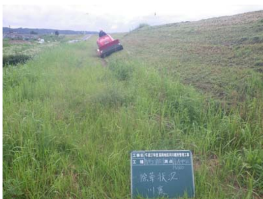
写真 5.2.3 堤防除草状況
