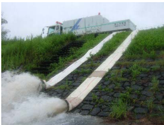
写真 5.2.9 排水ポンプ車による排水活動
