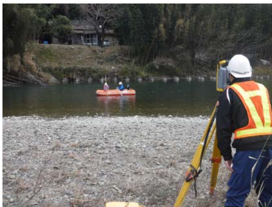
写真 5.2.1 河道の横断測量
