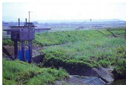
写真 2.1.4 河川管理施設（樋門）
