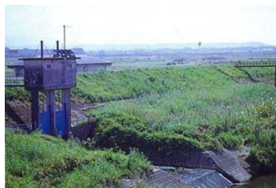
写真 2.1.4 河川管理施設（樋門）
