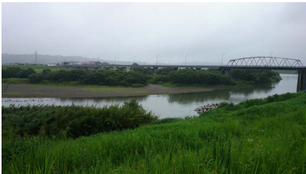
写真 2.1.1 河道内に繁茂する樹木群（本庄川柳瀬橋付近）
