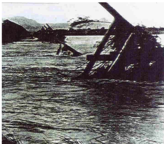
流失した高松橋（宮崎市）
