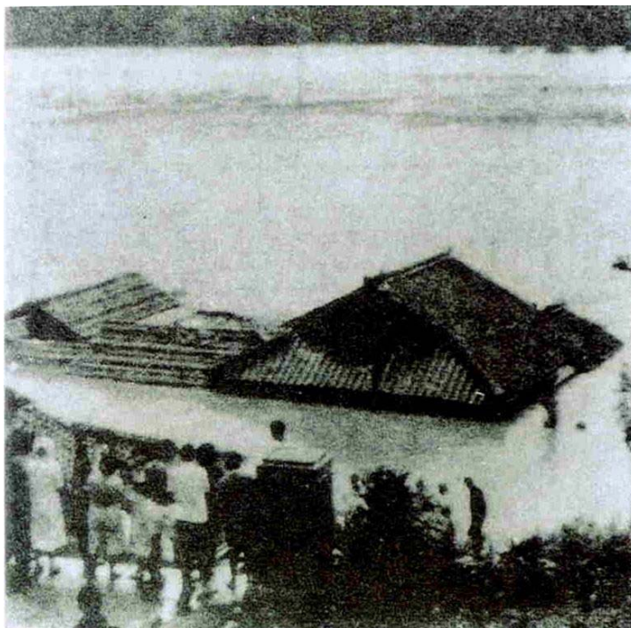
軒先まで浸水した家 (高岡町)
