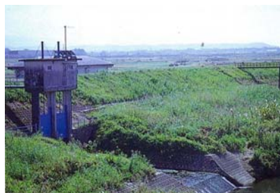
写真 2.1.4 河川管理施設（樋門）
