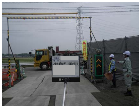
架空線対策管理者による高さ制限バー等の架空線に対する対策確認
