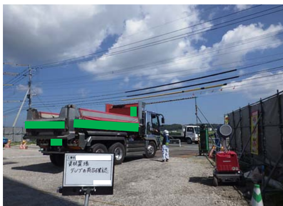
監視人によるダンプトラックの昇降状態確認及び退出指示
