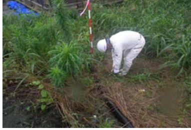
支障物周辺は手刈り作業とする
