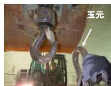
バックホウフック(玉元)側を外してから、くけい水路の吊金具を取り外す。
