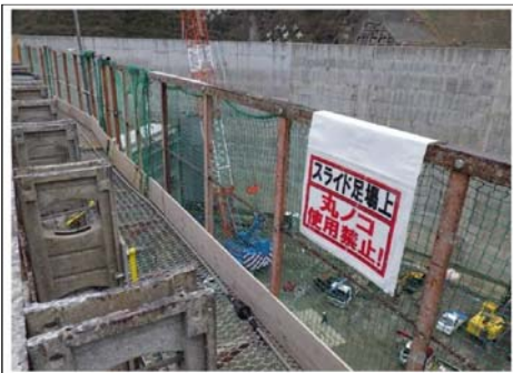
スライド型枠足場上では丸ノコは使用禁止とする。
