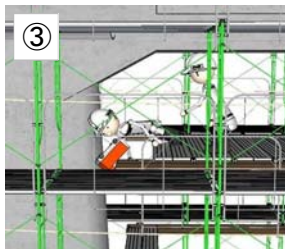
③探査データを保存する際に足を踏み外し、足場板と既設橋脚の隙間に転落した。
