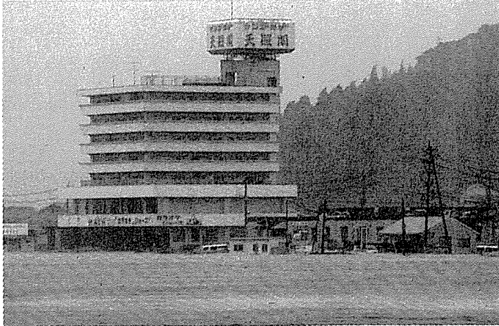
多くの建物が濁流にのまれた平成17年の台風14号水害。その後、防災計画も見直された（9月6日午後2時半ごろ、亀井橋から両富方面を撮影）
