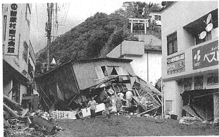
耳川の氾濫で壊滅的被害となった諸塚村中心部。上流には天然ダムもできた（平成17年9月7日）
