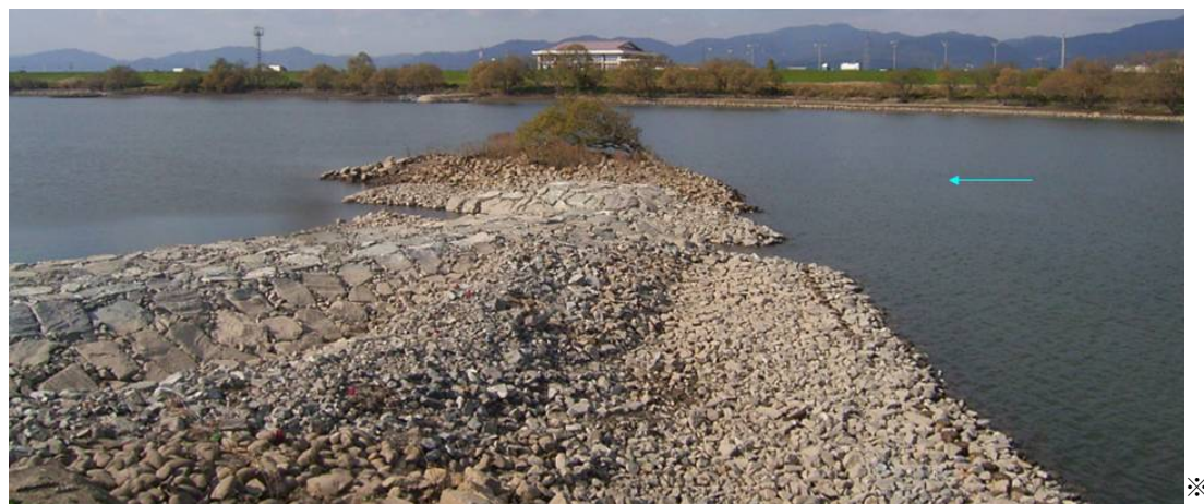
写真-18 筑後川安武町地先。既存の荒籠を修復・改良した杭打ち・石積み・石張り・雑石張りの構築様式による水制。要所に力石を配置している。
