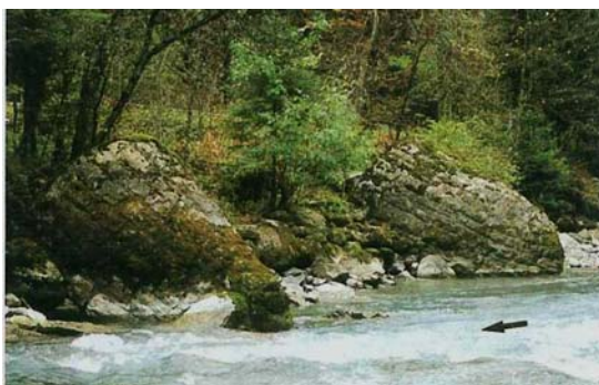
写真-13 スイスアルプス麓の渓谷に設置された胴部を短く頭部を低くした高水水制
