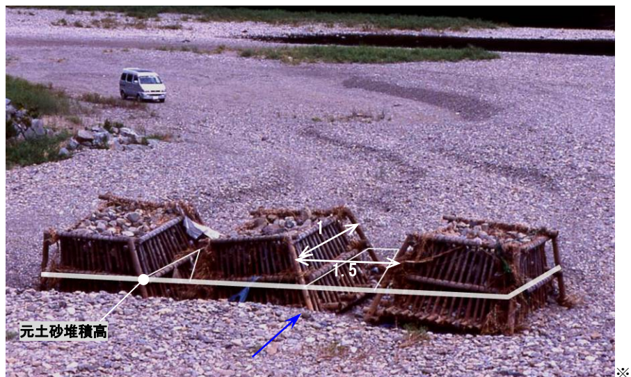
写真-33 一級河川番匠川（大分県）の土砂排除型ハイドロバリヤー水制
