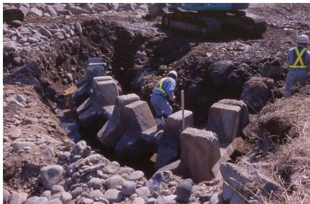
写真-11 土出しの水制で、頭部に置石と丸太の乱杭を配置した事例（福岡県遠賀川）
