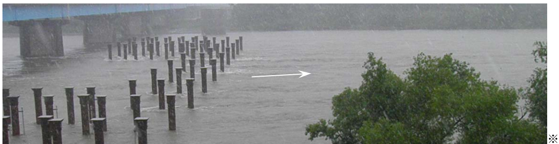
写真-7 同上。洪水時の水制 E 下流側の流況。流向は対岸に向かい、岸寄りの流速は緩やかである
