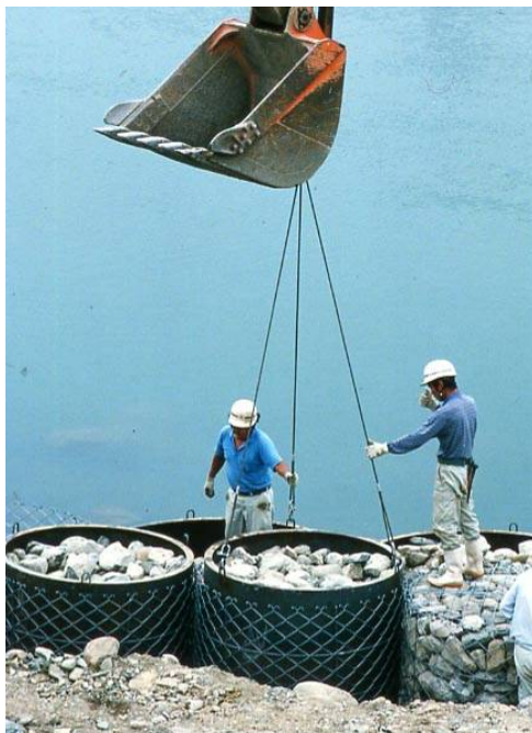
写真-10 鉄線には籠マット、蛇籠、ダルマ籠などの製品がある（熊本県球磨川）
