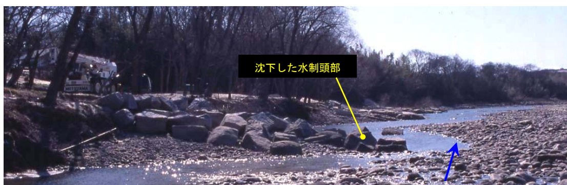
写真-15 2000年の東海豪雨で河岸堤防を護った矢作川の水制群 13) 。上流側の水制は頭部が河床に沈下して胴部を維持し、下流側の水制は完全に全形を保った
