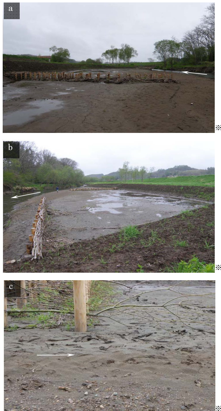
写真-31 北海道藻琴川の土砂捕捉を目的としたハイドロバリヤー水制
