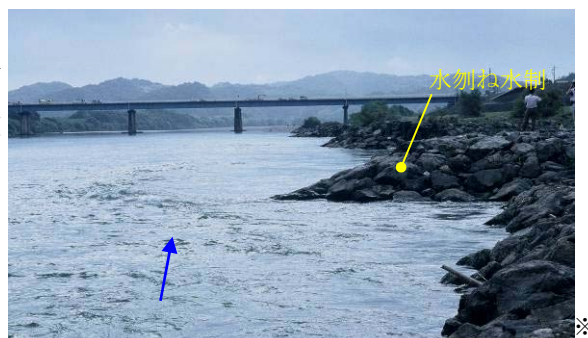
写真-8 水刎ね水制（高知県仁淀川）
