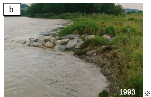
写真-2 同上トゥール川での水制。写真 a は水衝部に計画した隠れ水制群(水制全体を覆土しその水際を侵食させる)の配置図と、写真 b は工事完了後2年を経過した水際地形
