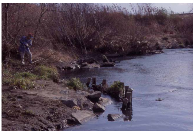
写真-11 土出しの水制で、頭部に置石と丸太の乱杭を配置した事例（福岡県遠賀川）
