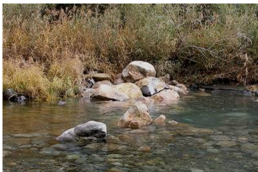
(a) 淵頭に設置した水制の工事完了
