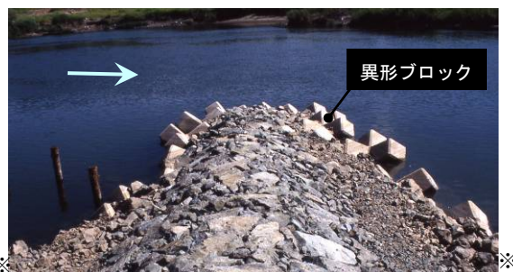
写真-17 異形ブロックを基礎にしている
