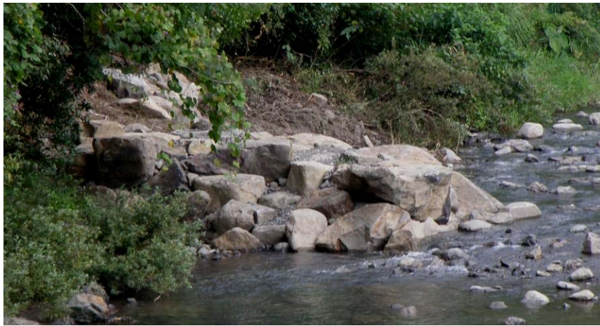
写真-20 高知県安田川。石積み、石張り(崩れ積み)水制 ※
