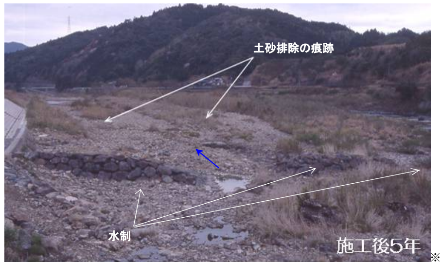
写真-32 高知県四万十川の土砂排除型ハイドロバリヤー水制
