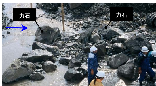
写真-16 頭部の隅角に力石を配置している
