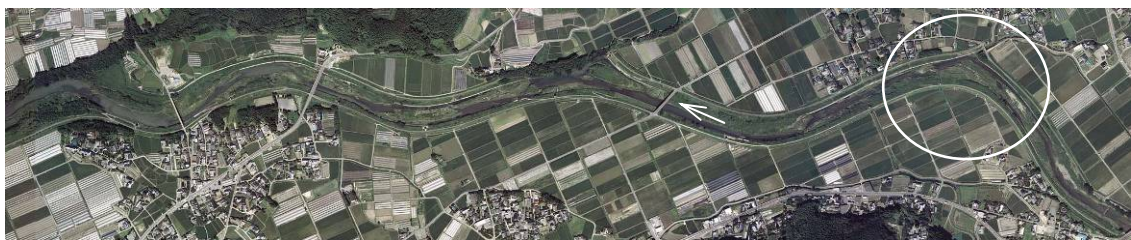
写真-28 菊池川との合流点から上流部の岩野川。モデル区間は右端の湾曲河道(白い丸印)
