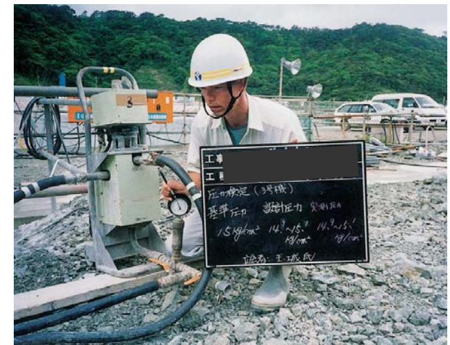
グラウチング状況 (他ダム事例)
