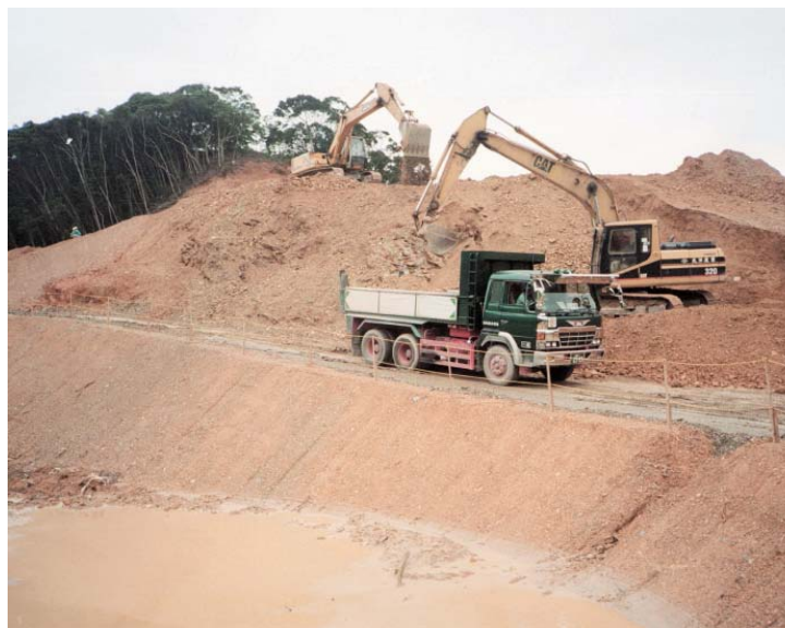
土捨て場施工状況 (他ダム事例)
