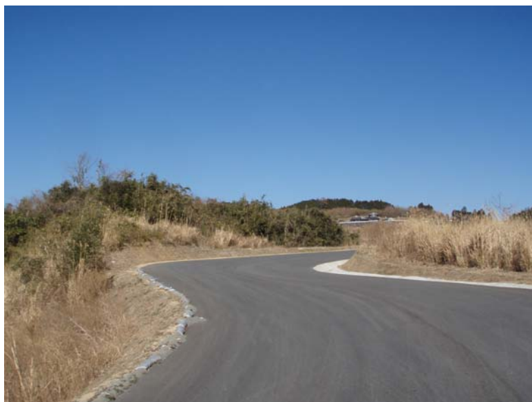
工事用道路完成写真
