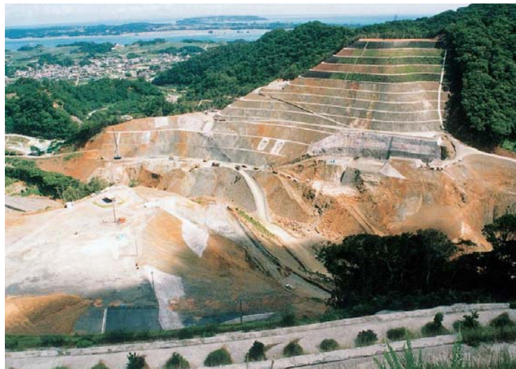
掘削状況 (他ダム事例)
