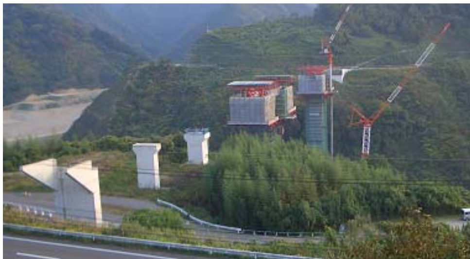
付替市道河内線整備状況
