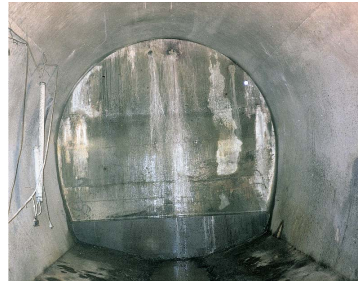
転流工閉塞状況 (他ダム事例)
