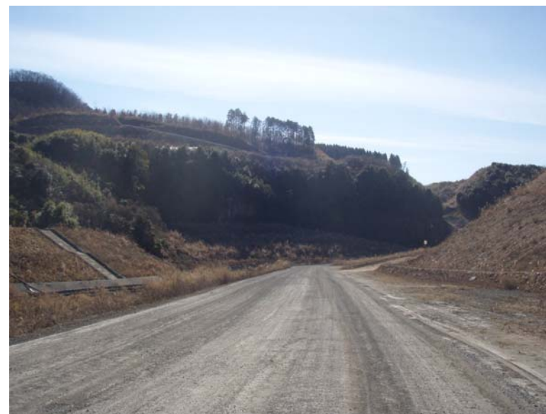
工事用道路完成写真
