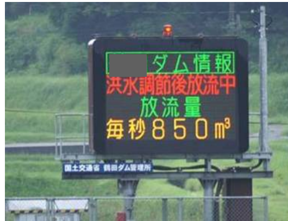
警報設備 (他ダム事例)
