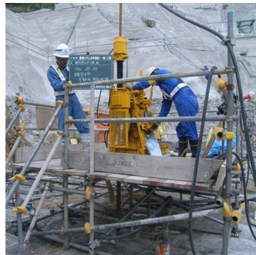
ボーリング状況 (他ダム事例)
