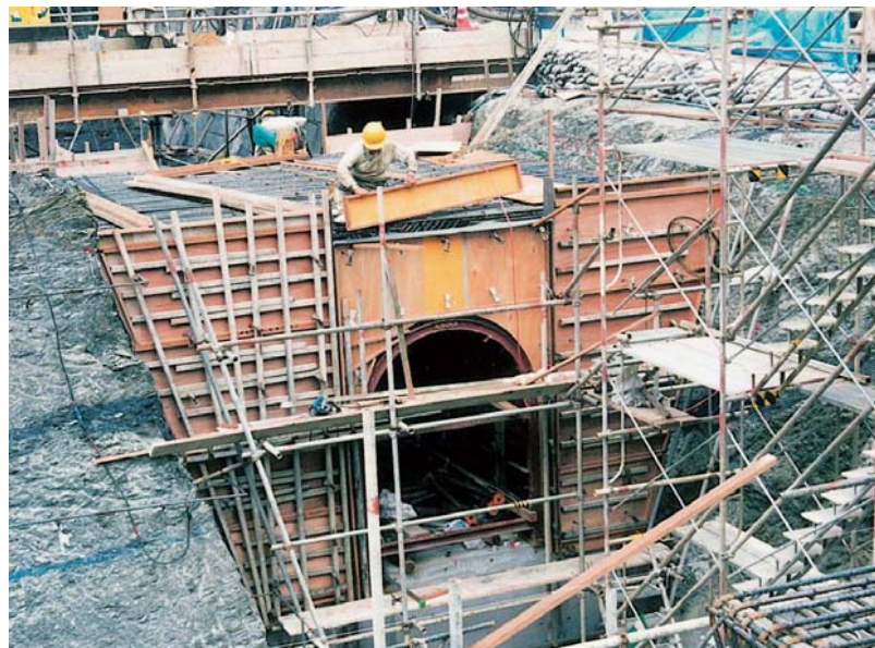
監査廊施工状況 (他ダム事例)
