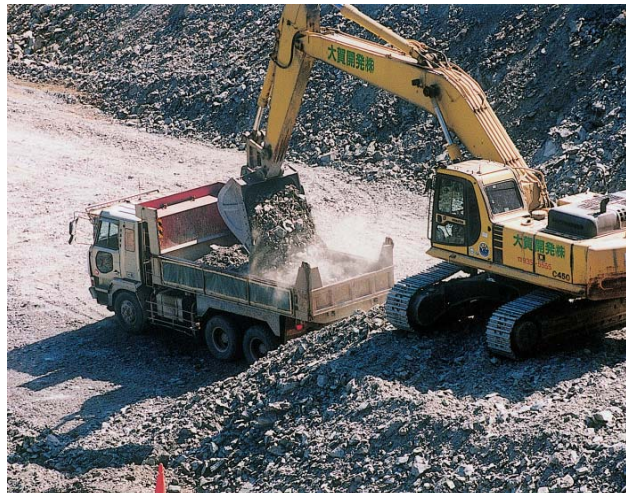
材料採取状況 (他ダム事例)
