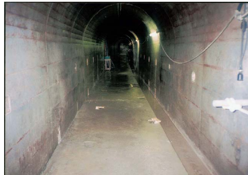
監査廊完成写真 (他ダム事例)
