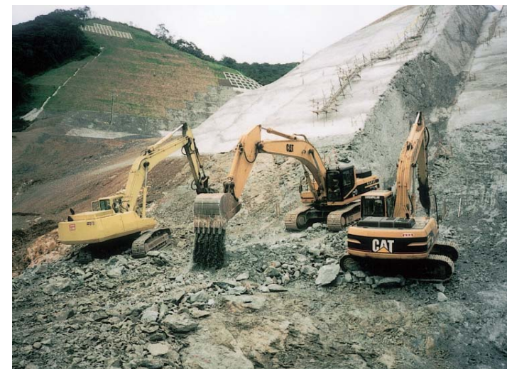
掘削状況 (他ダム事例)
