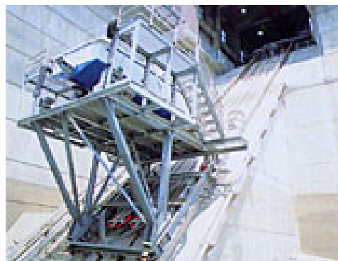
係船設備写真 (他ダム事例)
