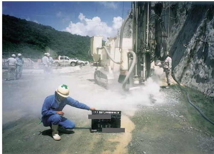
ボーリング状況 (他ダム事例)
