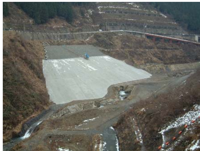
地すべり対策施工状況（他ダム事例）
