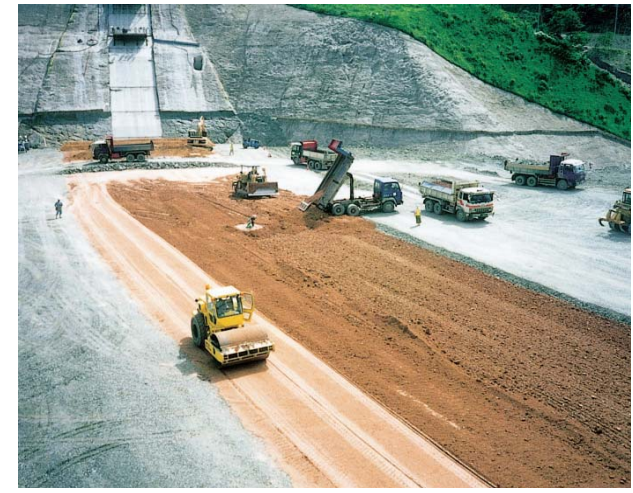
ダム本体盛立状況 (他ダム事例)
