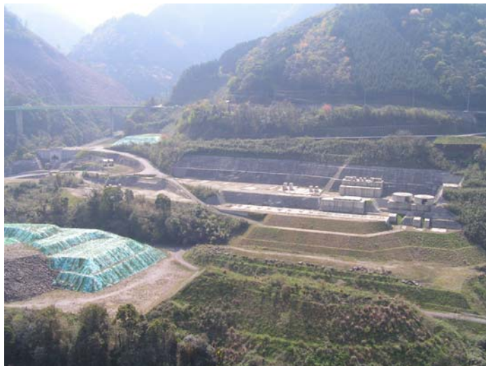
仮設備ヤード基盤造成写真 (他ダム事例)
