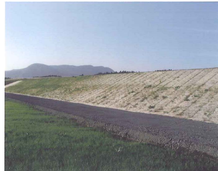
基盤整備の状況写真
