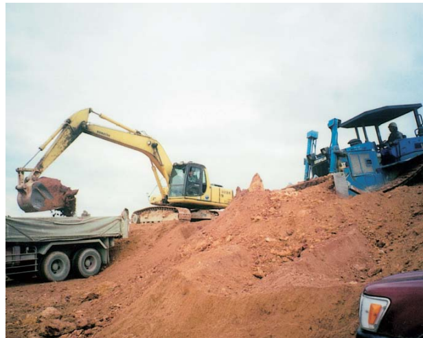
材料採取状況 (他ダム事例)
