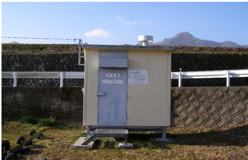
雨量観測所写真 (設置状況写真)
