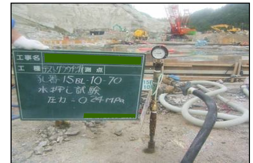
グラウチング状況 (他ダム事例)
