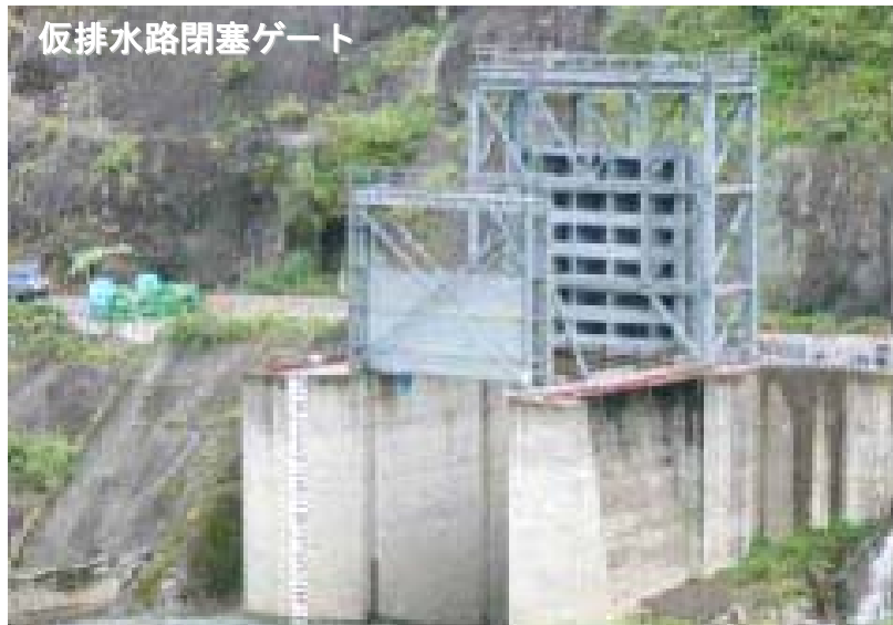
転流工閉塞状況写真 (他ダム事例)
