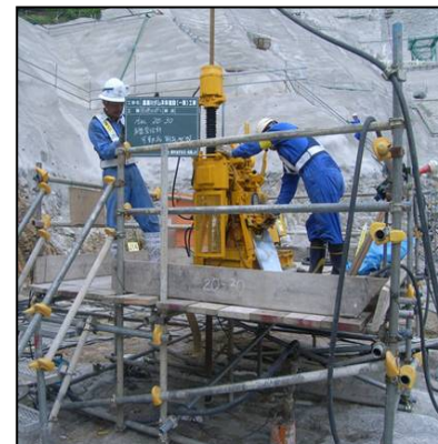
ボーリング状況 (他ダム事例)
