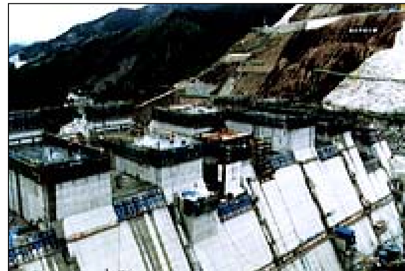
堤体工 (他ダム事例)
