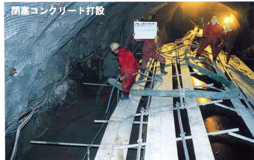
転流工閉塞状況写真 (他ダム事例)
