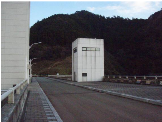
昇降設備写真 (他ダム事例)
