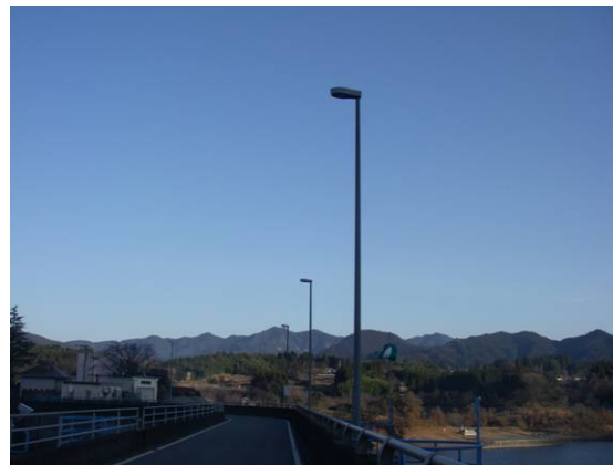
照明設備写真 (他ダム事例)
