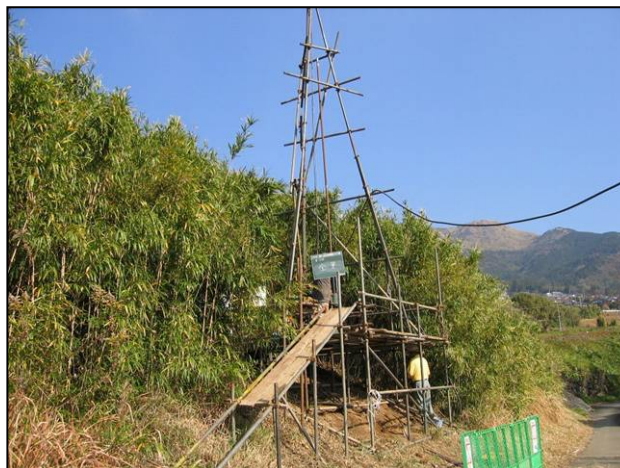
地質調査状況写真
