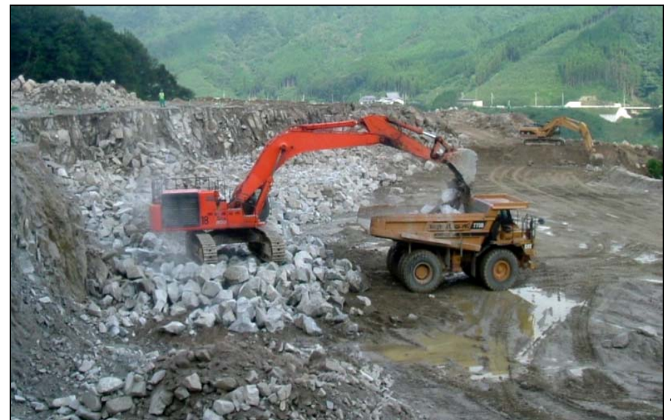
掘削工 (他ダム事例)
