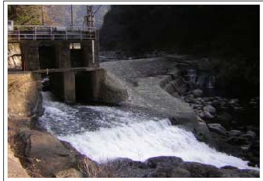
堤体にかかる九州電力取水堰（右岸下流より）
