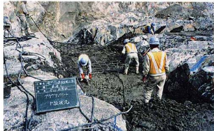
置換コンクリート (他ダム事例)
