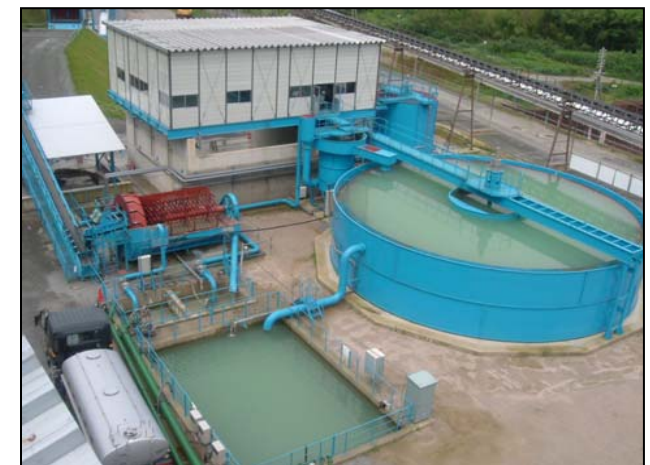
濁水処理施設(他ダム事例)
