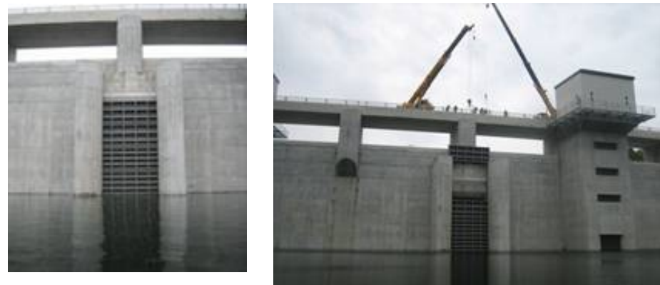
仮ゲート設置状況写真(他ダム)
