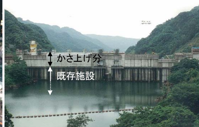
萱瀬ダム (長崎県：2級水系郡川)
