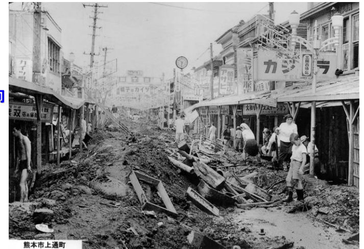
熊本市上通町 洪水後のヨナの堆積状況
