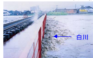
白川第一橋梁の状況
