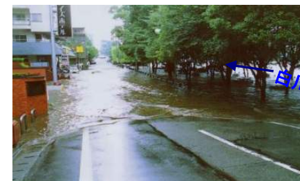
あんせい 安巳橋下流左岸の状況
