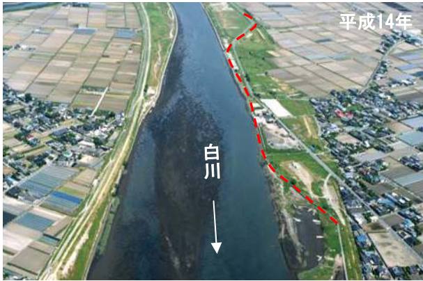
おきしん 白川高潮区間の堤防整備（沖新地区）
