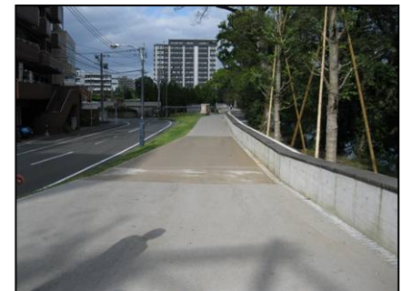
堤防の整備状況(右岸)
