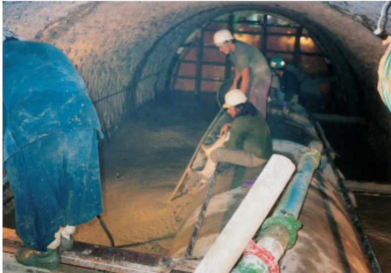
転流工閉塞状況写真 (他ダム事例)
