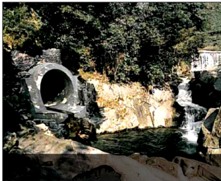
仮排水路トンネル（他ダム事例）
