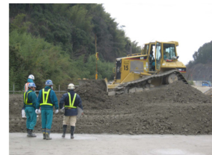
CSG材施工状況 (他ダム事例)
