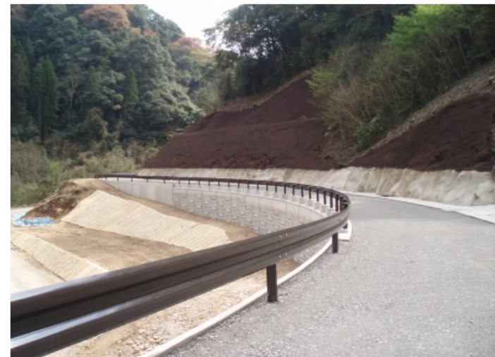
付替道路整備状況（他ダム事例）
