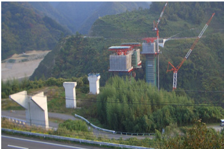
付替道路整備状況（他ダム事例）
