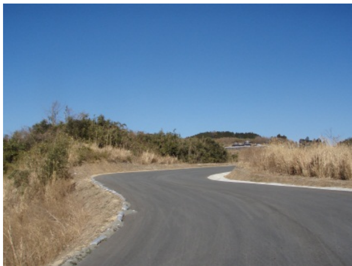
工事用道路写真（他ダム事例）
