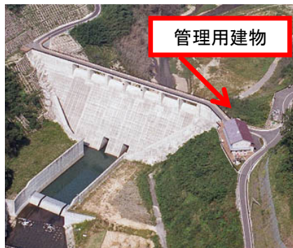
ダム管理所写真 (他ダム事例)
