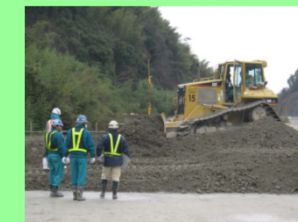
ダム本体工事
