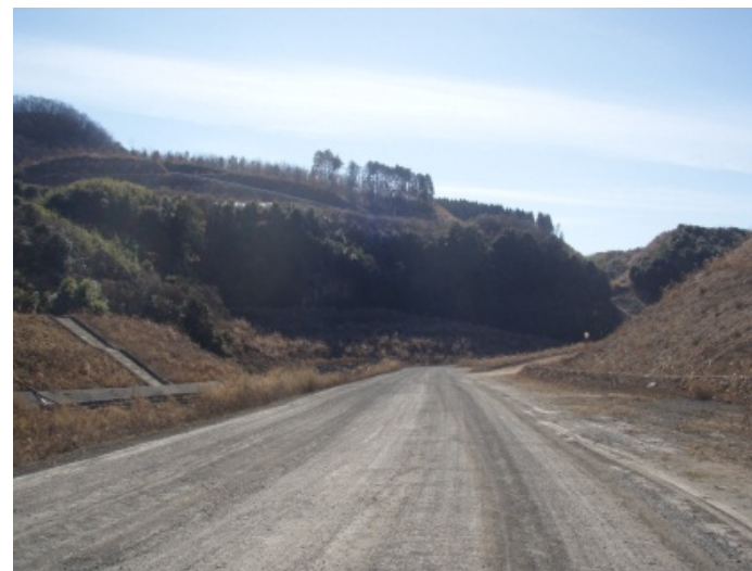
工事用道路写真（他ダム事例）
