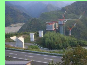
付替道路整備
