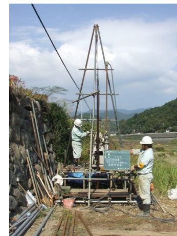
地質調査状況写真
