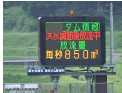
警報設備 (他ダム事例)
