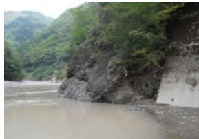
赤-3 上流側水位計
