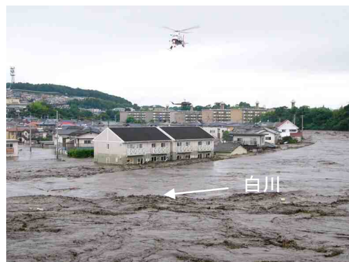
写真 2. 2. 13 熊本市龍田陳内地区の越水状況
