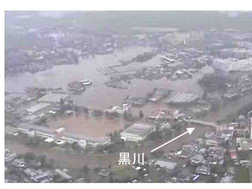
写真 2. 2. 15 阿蘇市内牧市街部の浸水状況
