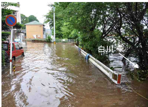
写真 2. 2. 10 明午橋右岸上流の越水状況
