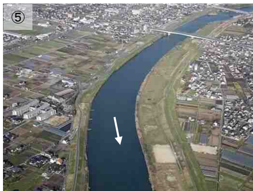
写真 2.1.5 白川下流部 [熊本市新土河原 しんとかわら ・薄場 うすば 付近]
