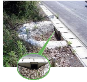
図 3.2.1 移動路のイメージ 写真 3.2.2 石を敷き並べた水路 写真 3.2.3 切り欠き側溝
