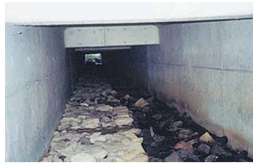
図 3.2.1 移動路のイメージ 写真 3.2.2 石を敷き並べた水路 写真 3.2.3 切り欠き側溝
