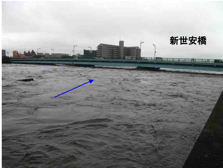
新世安橋付近の流下状況 (7/12 10:59)
