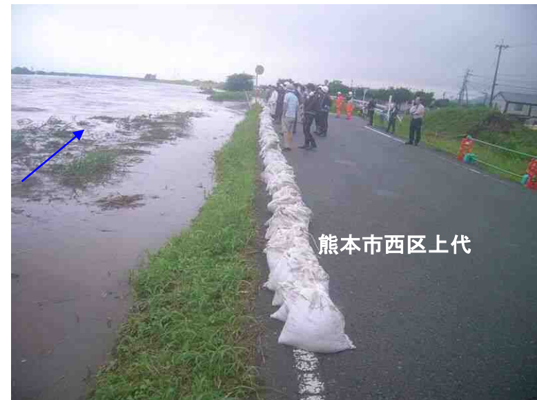
熊本西大橋下流右岸付近の状況 (7/12 11:01)
