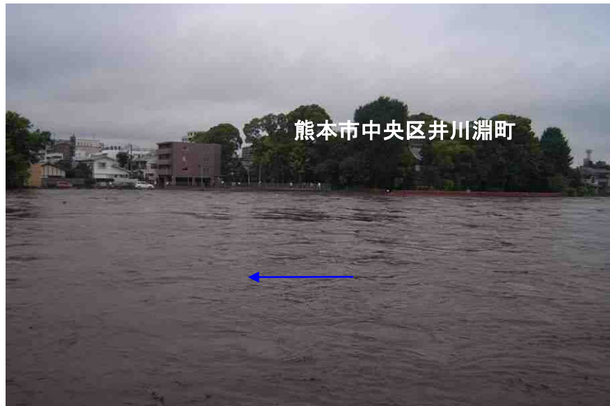
藤崎宮付近の流下状況 (7/12 11:30頃)
