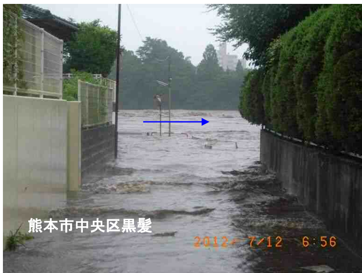
小碓橋下流右岸の越水状況 (7/12 6:56)
