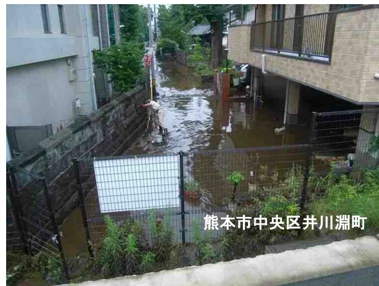
子飼橋下流右岸の浸水状況 (7/12 11:49)
