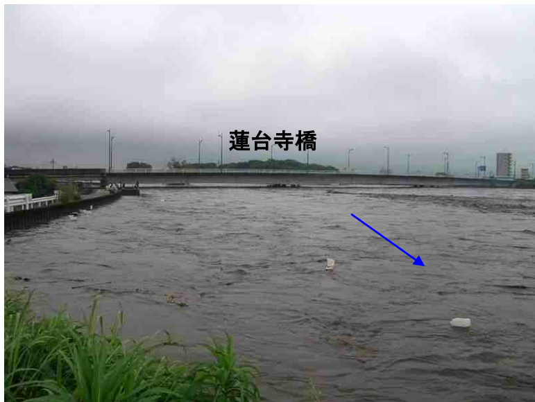
蓮台寺橋付近の流下状況 (7/12 11:24)
