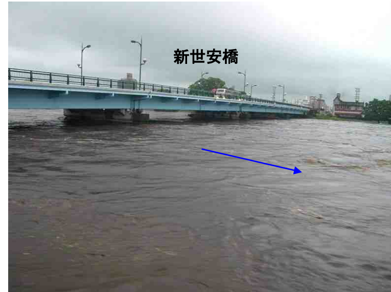
新世安橋付近の流下状況 (7/12 7:22)
