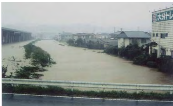
写真 2-2-7 平成 9 年 9 月洪水 尼ヶ瀬川の内水被害
