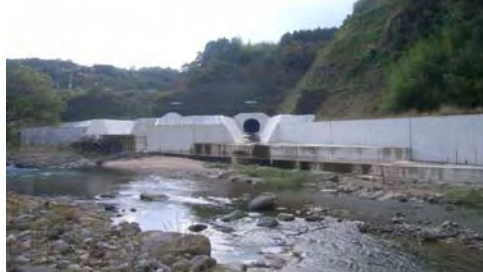
写真 3-3-4 仮排水路トンネル (平成 20 年 11 月完成)
