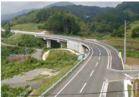
写真 3-3-1 付替国道 442 号 (平成 16 年 6 月完成)
