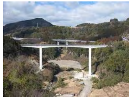
写真 3-3-2 付替市道尾原線 (平成 20 年 5 月完成)
