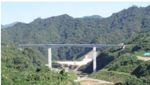
写真 3-3-3 河内橋 (仮称) (平成 24 年度完成予定)
