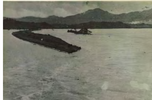
写真 2-2-4 昭和 28 年 6 月洪水 中州になった下郡築堤
