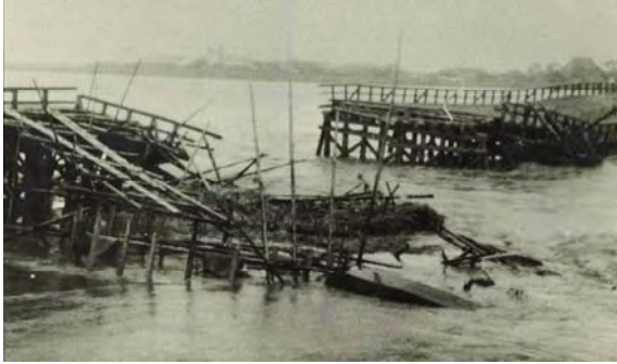
写真 2-2-3 昭和 28 年 6 月洪水 流失した舞鶴橋
