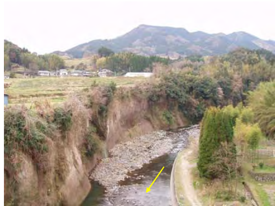
写真 2-1-2 中流部(峡谷部)
