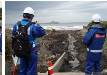
はん濫区域内にある流末状況の調査
