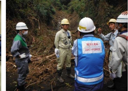
土石流検知センサー設置箇所の検討状況(泉津沢地先)
