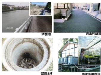
雨水貯留浸透施設の例
