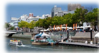
親水護岸の利用 (新町川／徳島市)
