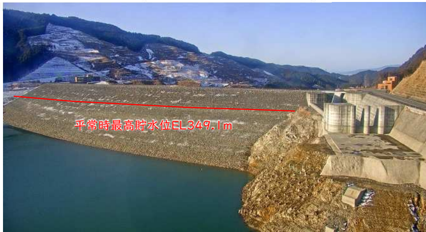
小石原川ダム現状(R8.1.26:EL320.97m)
