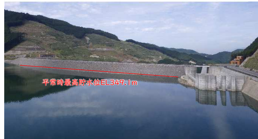
平常時最高貯水位付近の状況(R7.6.6:EL348.39m)
