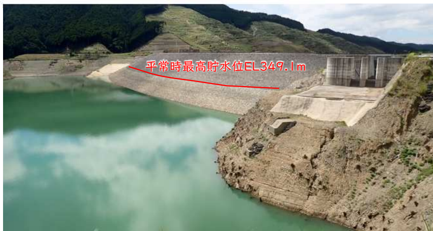
小石原川ダム現状(R8.9.2:EL321.75m)
