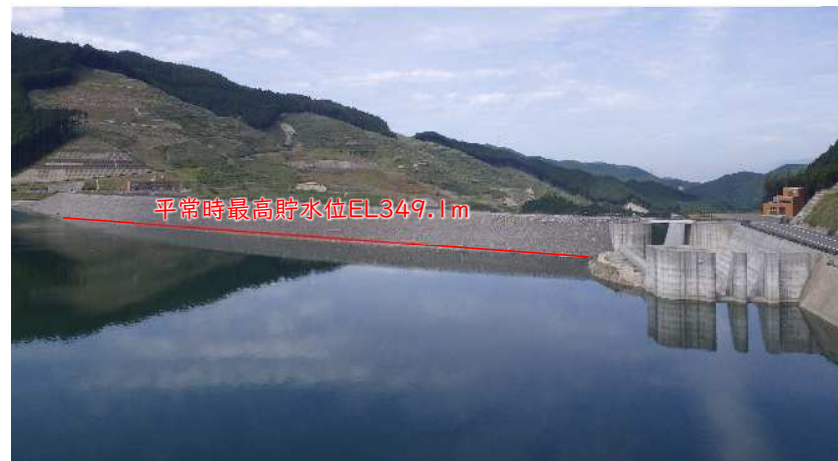
平常時最高貯水位付近の状況(R7.6.6:EL348.39m)
