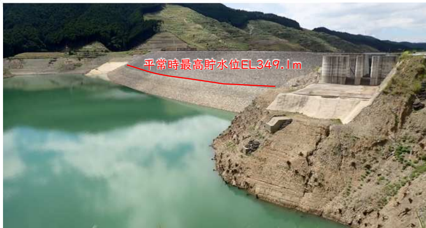
小石原川ダム現状(R8.9.2:EL321.75m)
