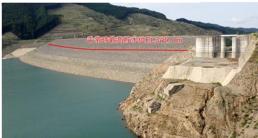
小石原川ダム現状(R8.9.16:EL321.66m)
