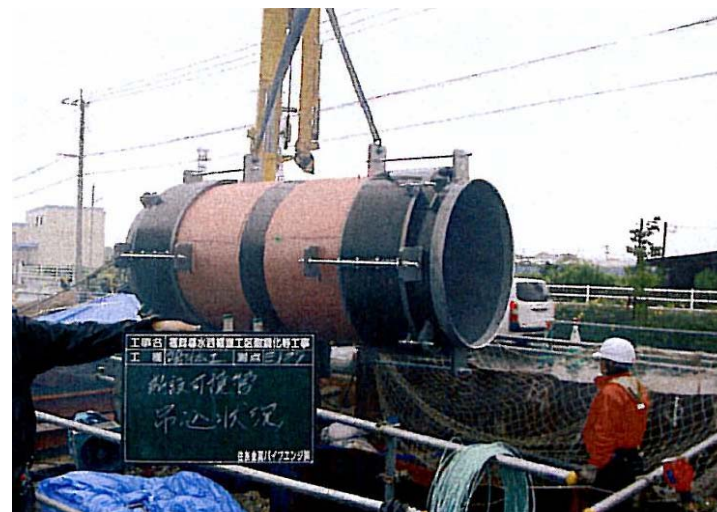
導水管埋設 (他事業事例)
