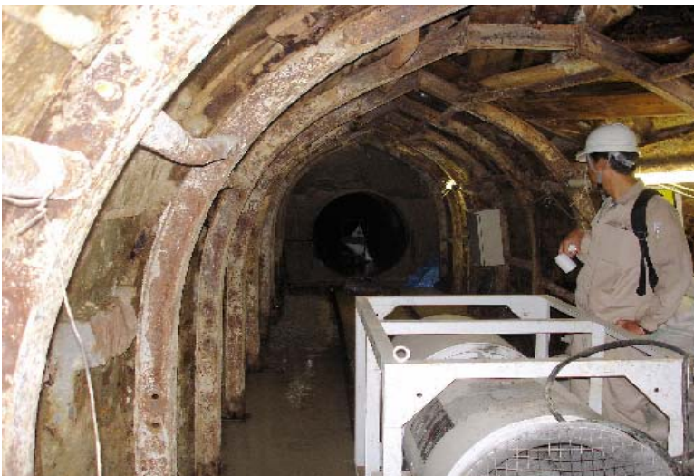
トンネル工 (他事業事例)
