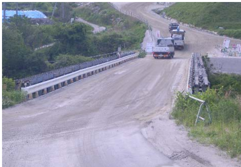
工事用道路(他事業事例)
