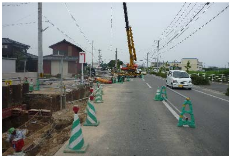
導水管埋設 (他事業事例)
