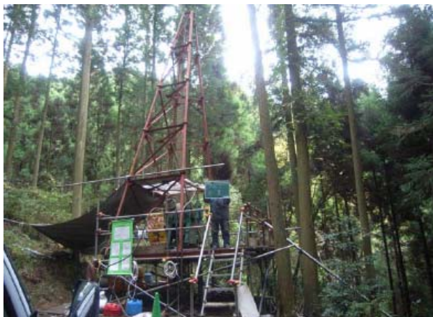
地質調査状況写真
