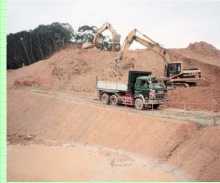
仮設備(土捨場造成)
