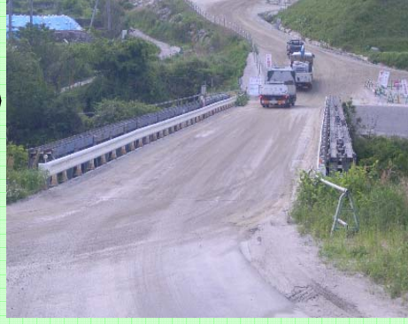
仮設備(工用道路)
