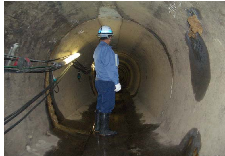
トンネル工 (他事業事例)
