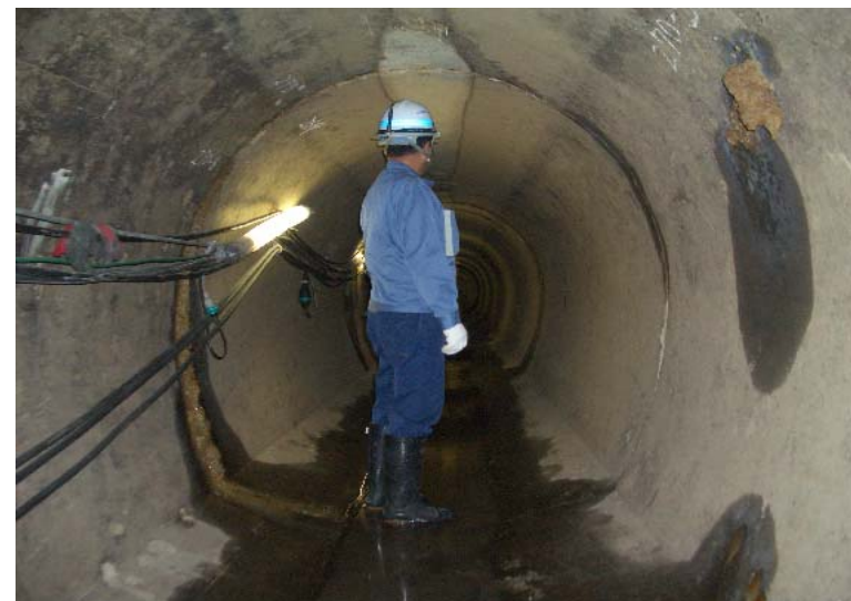
トンネル工 (他事業事例)
