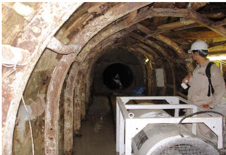
トンネル工 (他事業事例)
