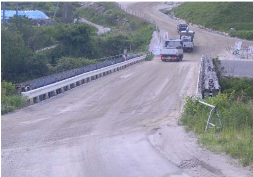
工事用道路(他事業事例)
