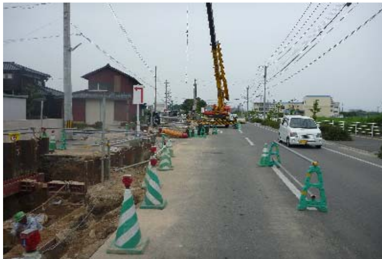
導水管埋設 (他事業事例)
