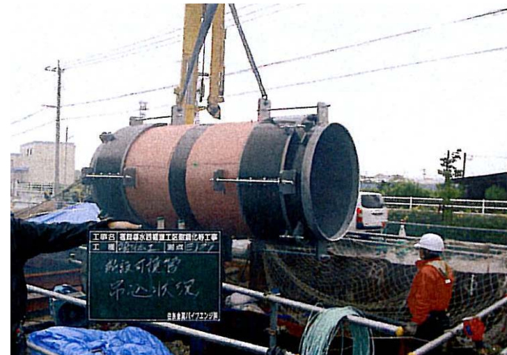
導水管埋設 (他事業事例)
