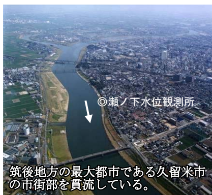
写真 2.1-7 久留米市周辺 (豆津橋 まめづ 付近) 【瀬ノ下水位観測所付近】
