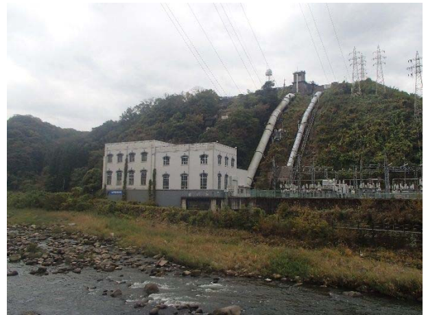
写真 2.2-5 女子畑発電所（日田市天瀬町）
