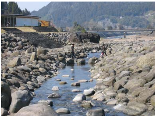
写真 2.4-1 西大山水辺プラザ（日田市）
