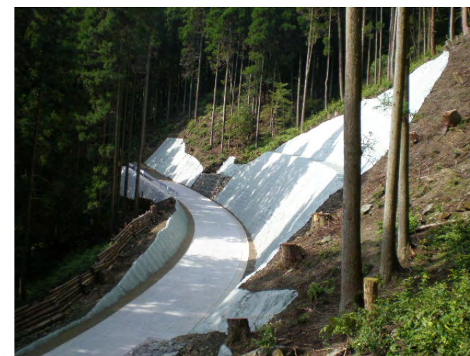
付替林道進入路
