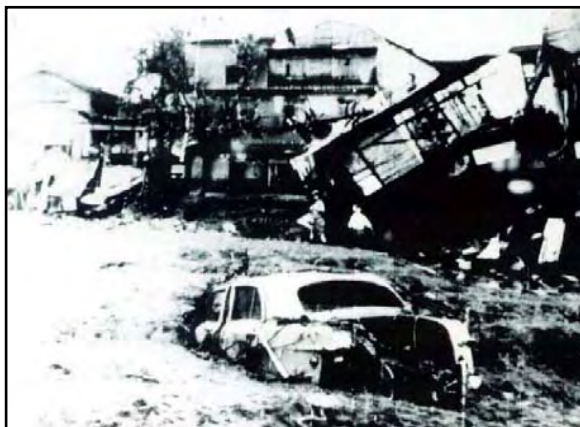
はらづる 壊滅的な被害を受けた原鶴温泉街
