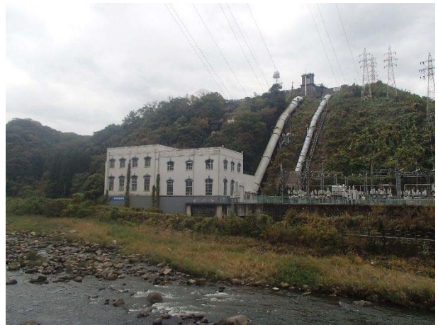
写真 2.2-5 女子畑発電所（日田市天瀬町）
