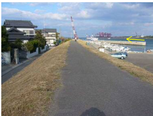
写真 2-3-1 高潮堤防状況 (大分市豊海)
