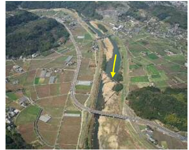
写真 2-3-12 七瀬川 (霊山橋付近)
