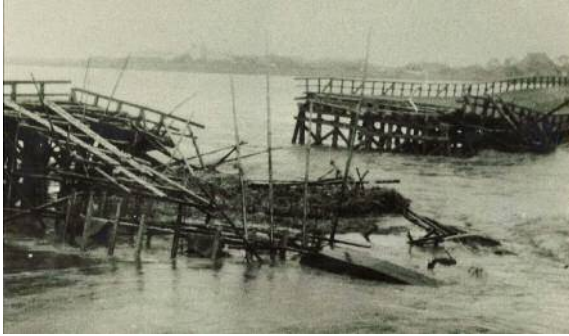
写真 2-2-3 昭和 28 年 6 月洪水 流失した舞鶴橋
