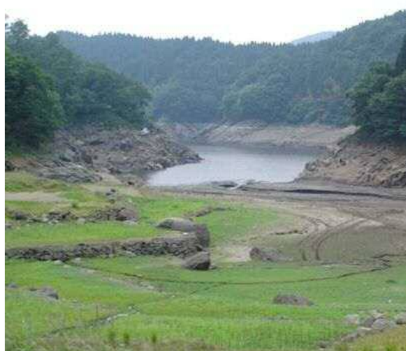
写真 2-2-12 少雨のため水位が大きく低下した芹川ダム(平成 17 年 6 月)
