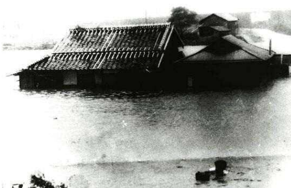
写真 2-2-5 昭和 32 年 9 月洪水 大分川明碓地区で床上まで 浸水する家屋
