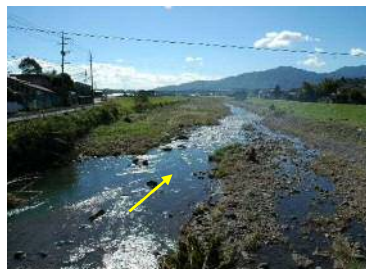
写真 2-3-21 上流側の瀬 おぼたけ (小畑橋付近)
