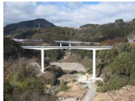
写真 3-3-2 付替市道尾原線 (平成 20 年 5 月完成)
