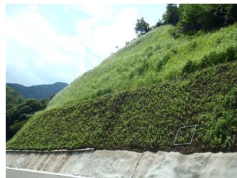
写真 3-2-4 種子吹付法面
