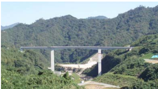
写真 3-3-3 河内橋 (仮称) (平成 24 年度完成予定)
