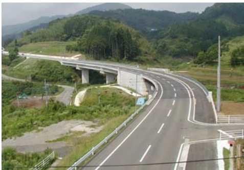
写真 3-3-1 付替国道 442 号 (平成 16 年 6 月完成)
