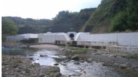
写真 3-3-4 仮排水路トンネル (平成 20 年 11 月完成)
