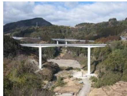
写真 3-3-2 付替市道尾原線 (平成 20 年 5 月完成)
