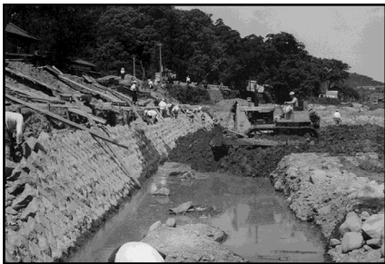
昭和32年7月諫早大水害後の工事状況
