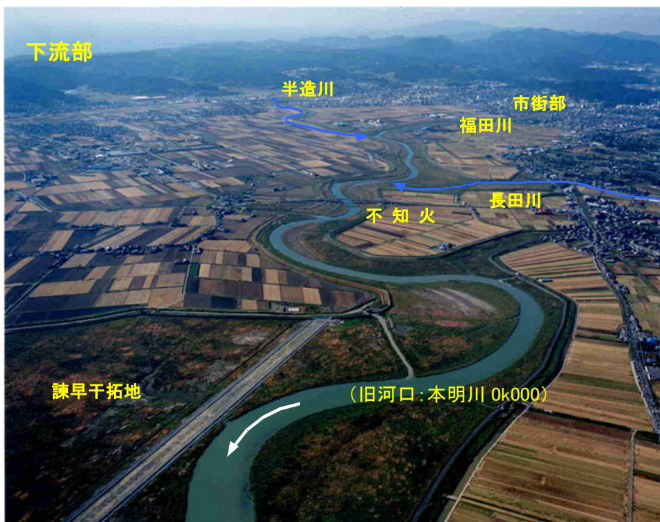
写真 2.1-12 本明川の下流（旧河口付近）
