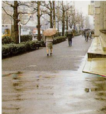
透水性ブロック舗装
