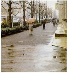
透水性ブロック舗装
