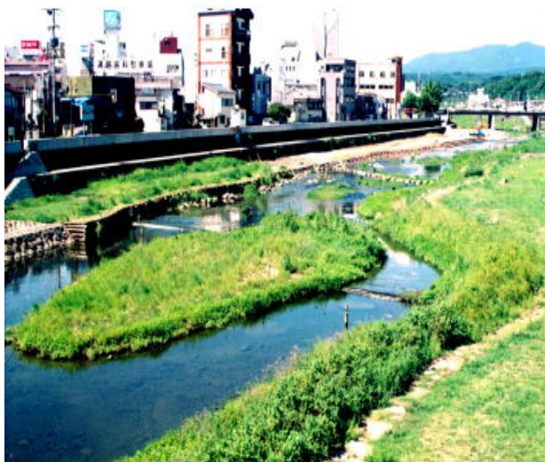
写真 2.1-9 中流部の河川環境 (旧河口から 5.6km 付近)
