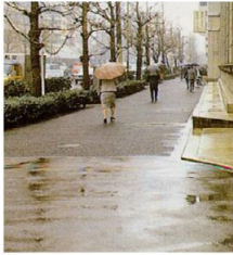
透水性ブロック舗装
