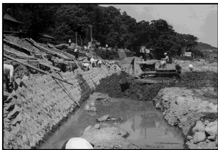
昭和32年7月諫早大水害後の工事状況
