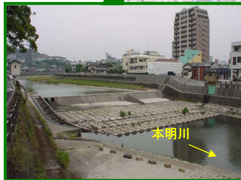
公園堰(本明川5k100付近)
