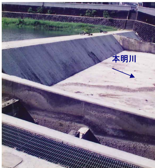
公園堰と魚道の状況 平成6年8月撮影
