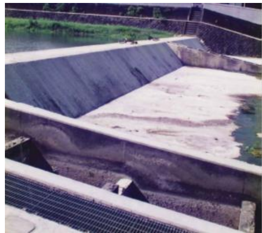
写真 2.3-2 平成6年 公園堰
