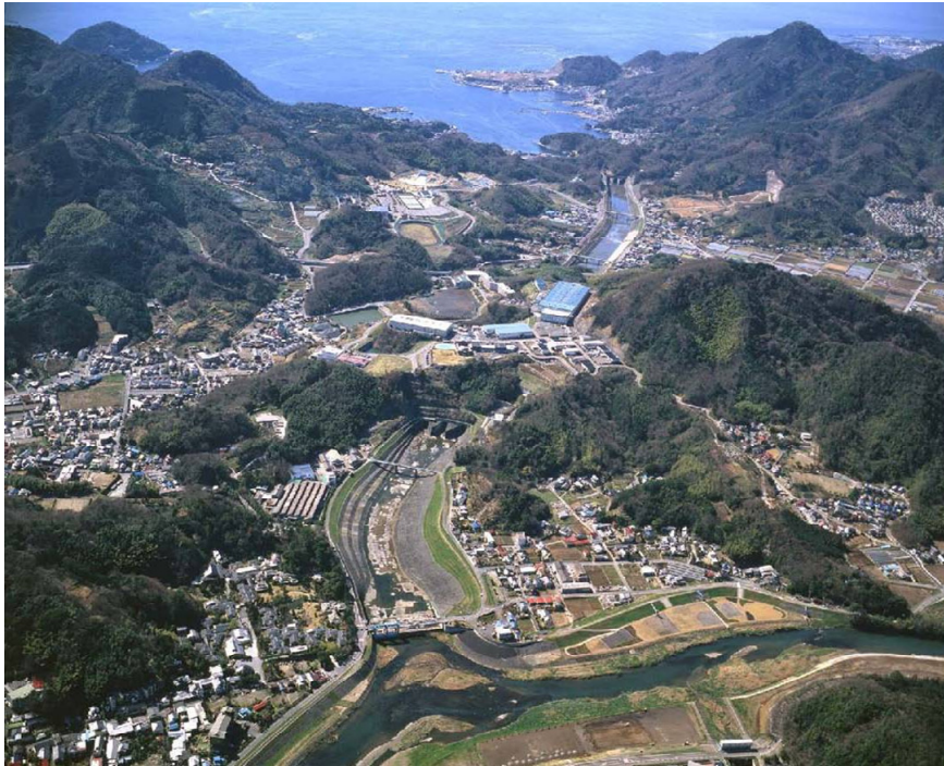
狩野川放水路
