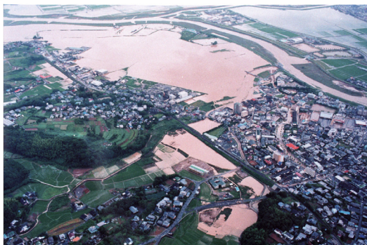
平成 11 年 7 月出水：諫早市街地（上空写真）
