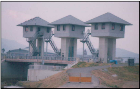
中山西川水門 (平成9年度完成)
