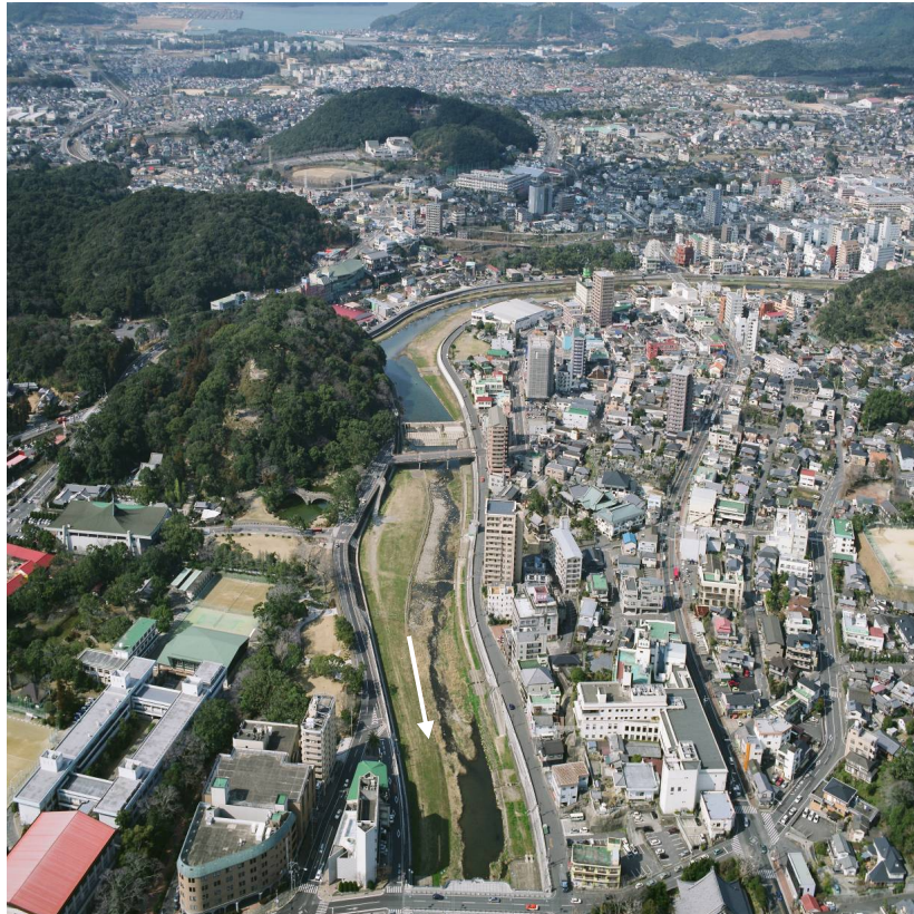
写真 2.1-8 本明川の中流（諫早市街部付近）
