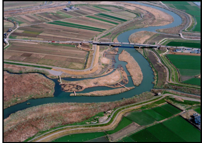
本明川下流河道掘削 (平成10年度~)
