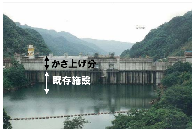
萱瀬ダム (長崎県: 2級水系郡川)
