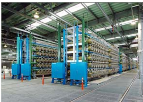
高圧RO膜設備
