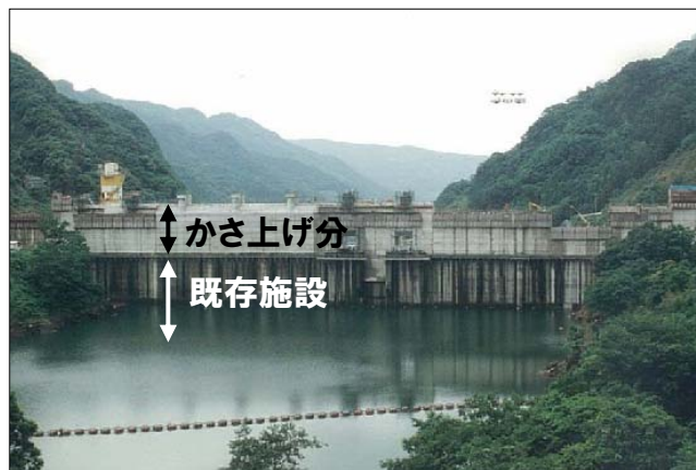
菅瀬ダム (長崎県:2級水系郡川)
