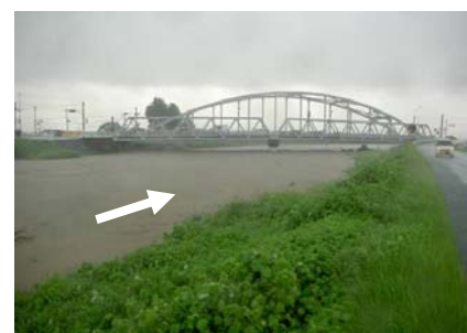
写真 2.3-1 平成21年7月洪水 (神埼橋付近)
