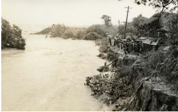
写真 2.2-7 城原川堤防決壊
