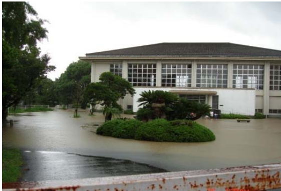
写真 2.2-30 神埼小学校の浸水状況
