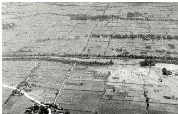
写真 2.2-6 城原川堤防決壊
