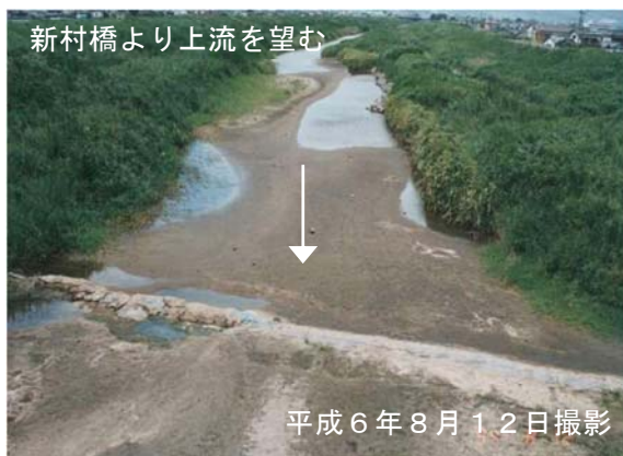
写真 2.2-46 渇水時状況写真
