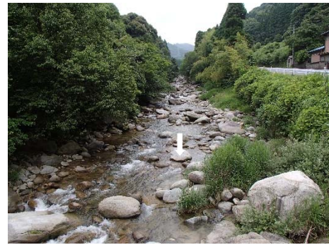
写真 2.1-15 向山橋より上流
