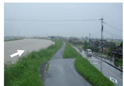
写真 2.3-2 平成22年7月洪水 (新村橋付近)
