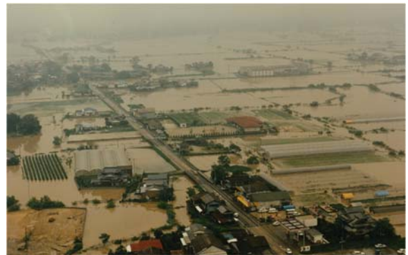
写真 2.2-19 神埼市（旧千代田町）の 浸水状況
