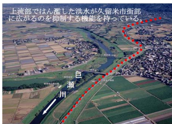
写真 2.2-1 巨瀬川左岸の控堤(久留米市)
